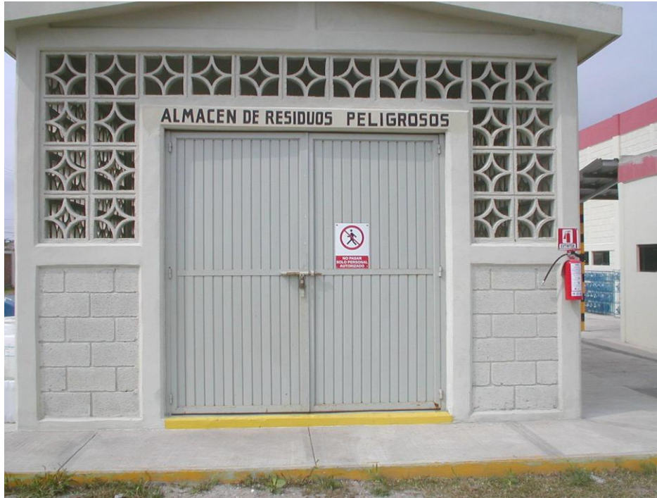
Figura 10. Almacén temporal de residuos peligrosos.
